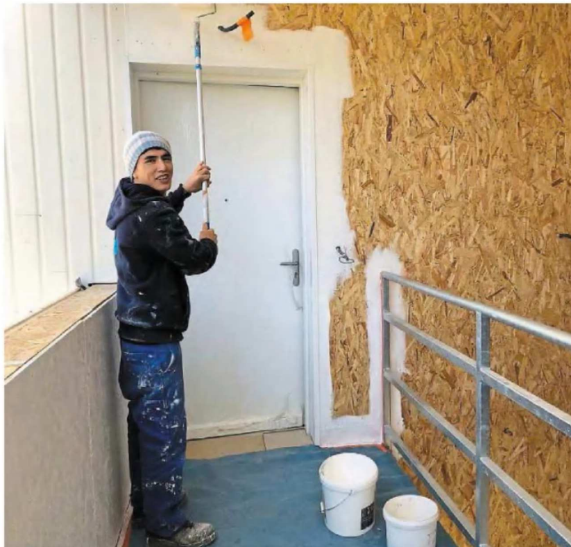
Sur le chantier de son futur logement, Ali Jan a découvert des métiers et rêve de devenir peintre. PO-ST
