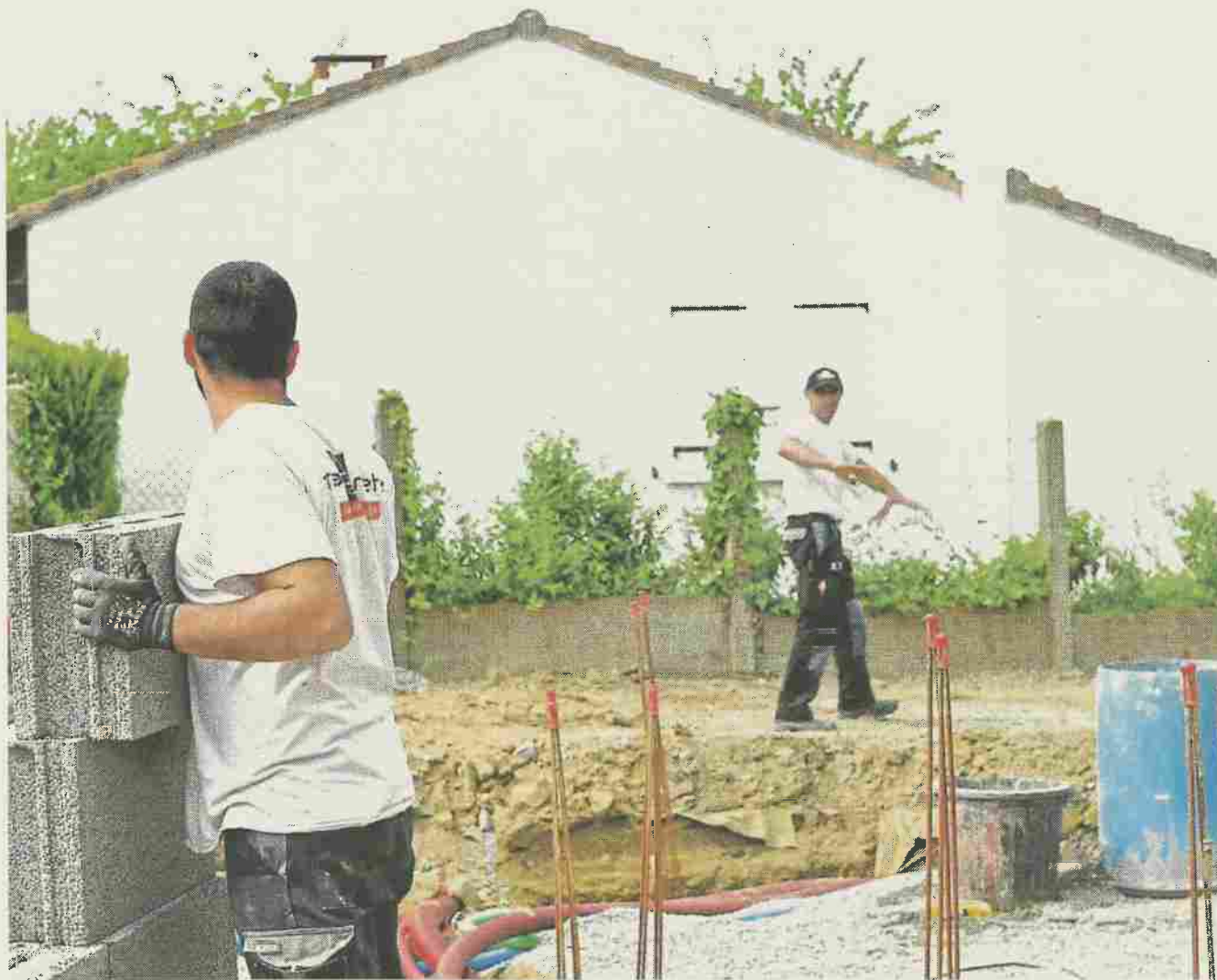
Reprise progressive chez Macoretz, les ouvriers doivent respecter des gestes barrière.
